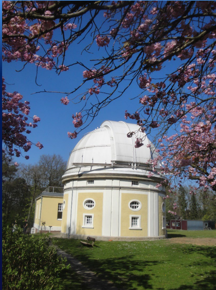
1m-Spiegelteleskop-Gebäude der Hamburger Sternwarte in Bergedorf, FHS: Sanierung 2008-2010, Restaurierung 1m-Spiegelteleskop (2011/12)
