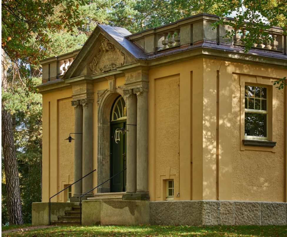
Abb. 7: Gebäude des Großen Refraktors (B2 1907–09), instand gesetzt 2015–19. In die repräsentativen Säulenportale der Eingangstüren der Vorbauten, die durch einen schmalen Gang mit dem Kuppelgebäude verbunden sind, wurde jeweils die Teleskopbezeichnung eingemeißelt. Foto: Michaela Becker, Oktober 2021
