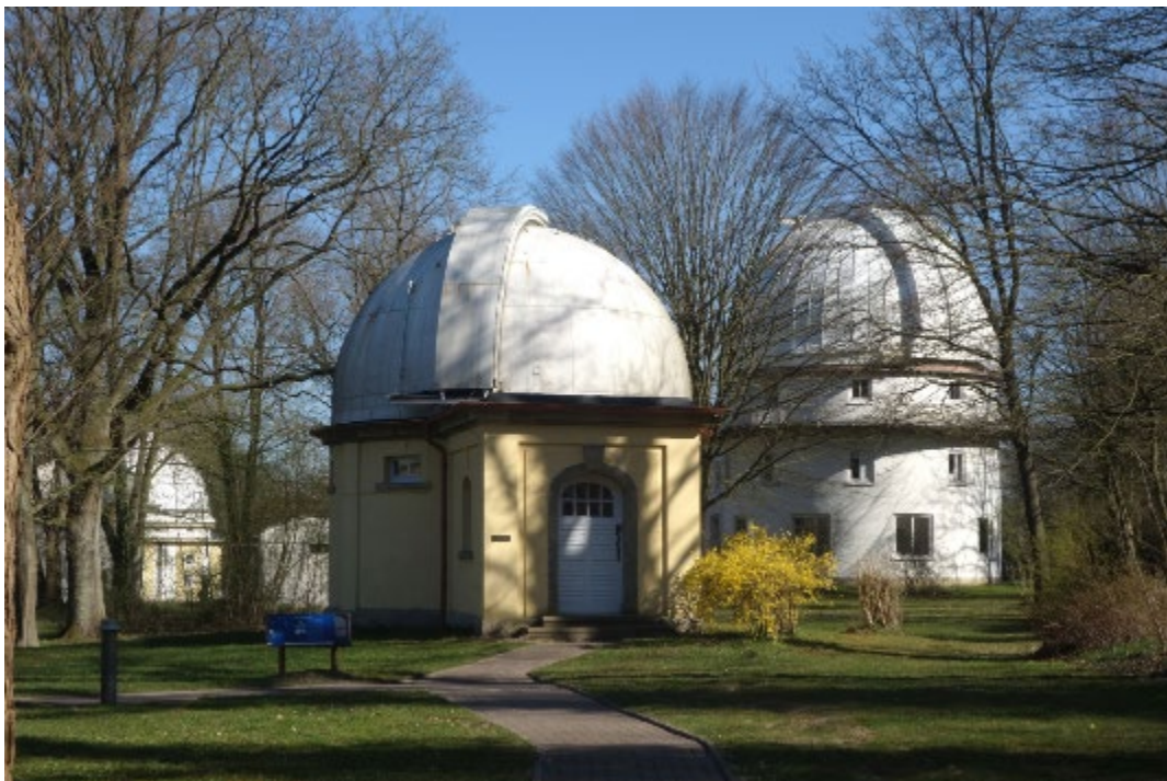
Abb. 10: Im Vordergrund steht das Kuppelgebäude des Äquatorials (B3) (1907–09), dessen Kuppel von 1855 von der alten Hamburger Sternwarte abmontiert und hier wieder aufgebaut wurde. Instand gesetzt 2004–05. Rechts sieht man das Gebäude für das Oskar-Lühning-Teleskop (B11), Foto: Matthias Hünsch, April 2020
