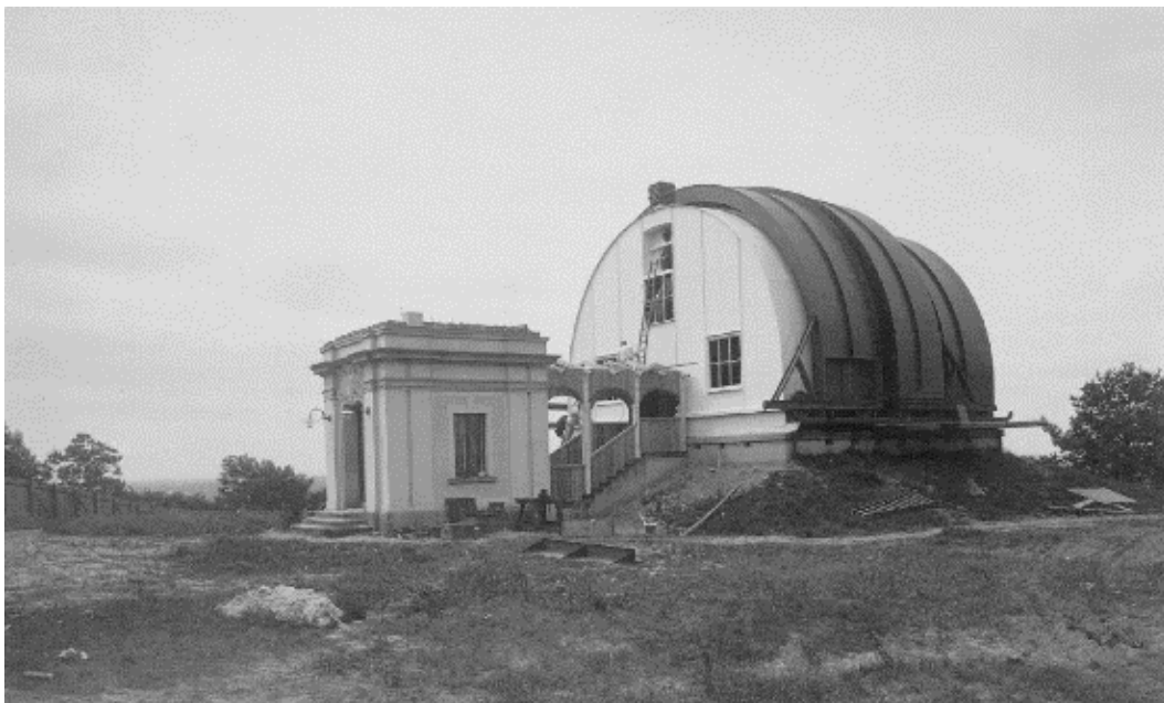
Abb. 5: Das Gebäude des Meridiankreises (B1) auf dem höchsten Punkt des Geländes kurz vor der Fertigstellung. Diese Aufnahme von 1909 zeigt gut, dass die Kuppelgebäude auf einem Sockel ruhen. Foto: Archiv der Hamburger Sternwarte
