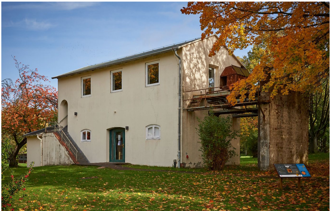
Abb. 18: Sonnenbau (B10 1942), enthielt ursprünglich ein horizontal montiertes Teleskop für Sonnenbeobachtungen, heute Seminar- und Schulungsräume. Foto: Michaela Becker, Oktober 2021
