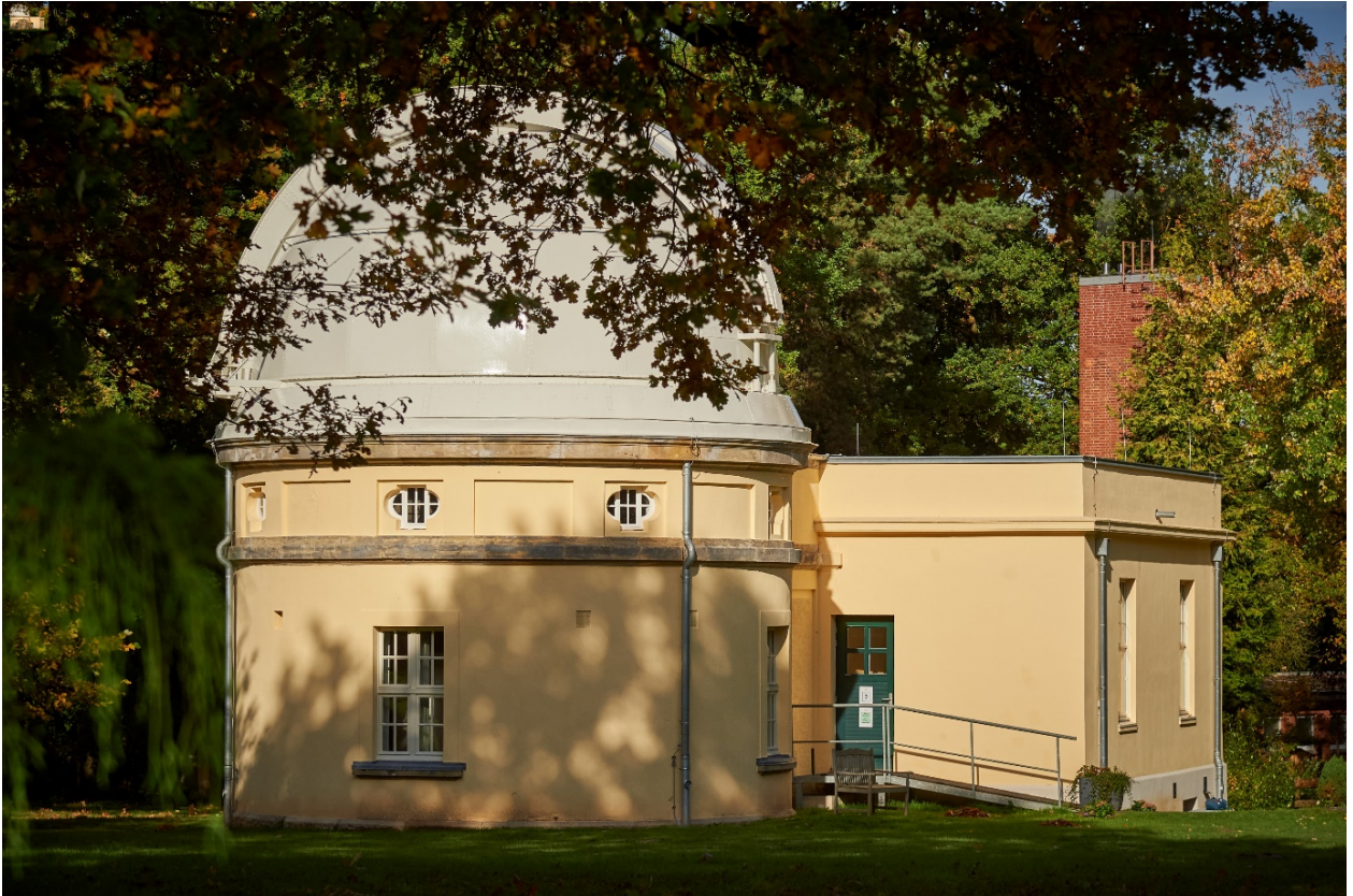
Abb. 17: Gebäude für den Lippert-Astrographen (B5), einem fotografischen Fernrohr (1907–09, Anbau 1926), instand gesetzt 2019-2021, Foto: Michaela Becker, Oktober 2021
