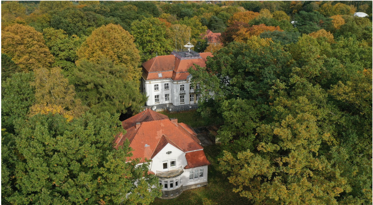
Abb. 24: Direktorenwohnhaus (W1) (1906–09), eine zeittypische verputzte Villa mit malerisch gestalteter Dachlandschaft und einer Halle mit Kamin. Im Hintergrund das Hauptdienstgebäude. Foto: Bernd Paulowitz, Oktober 2021
